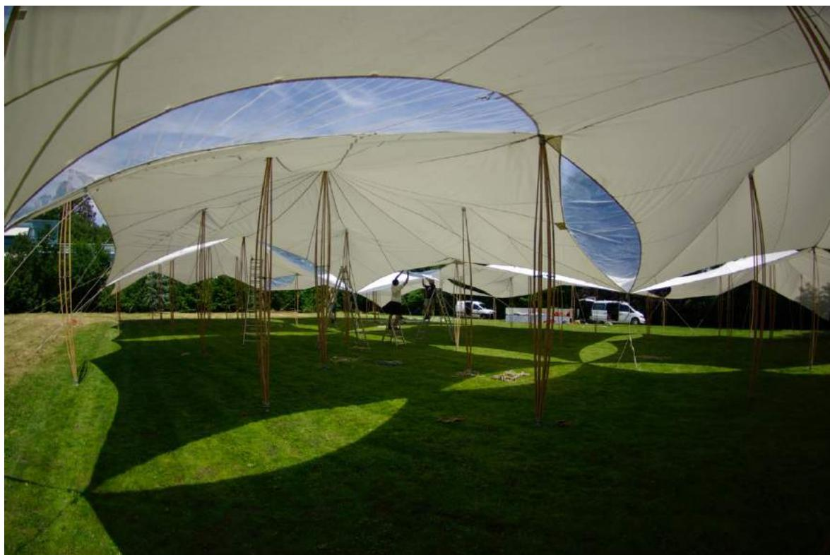
Principe modulaire des BambouHalls reliés entre-eux par vulves transparentes en membrane ETFE
