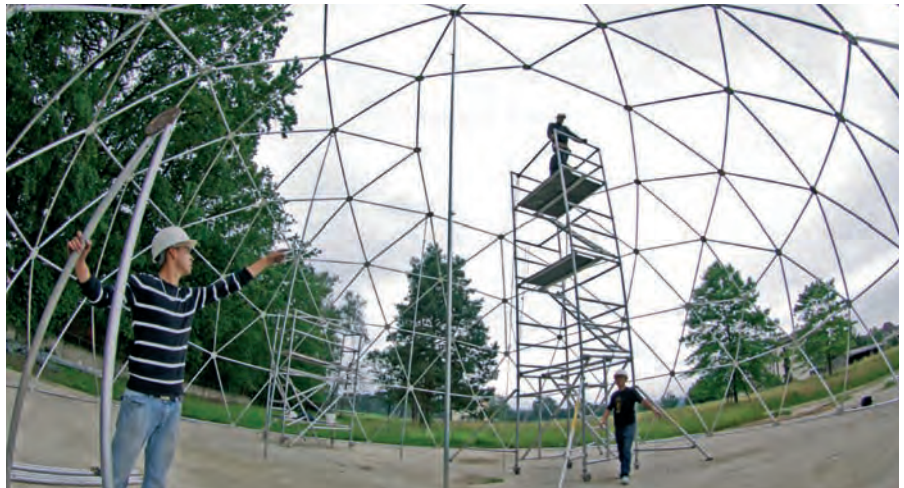
Montage d'un SwissDôme de Mamajah à Loëx destiné à servir d'atelier polyvalent
